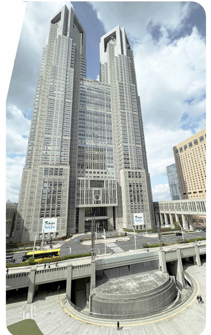
第2庁舎2階の窓から見た第1庁舎 都知事の居る場所は未公開
